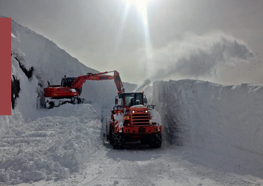
Abb 3 Die Schneeräumung bedingt insbesondere nach grossen Lawinenabgängen einen erheblichen Maschinen- und Zeitaufwand. Räumungsfahrzeug im Lawinenzug Nr. 34.
